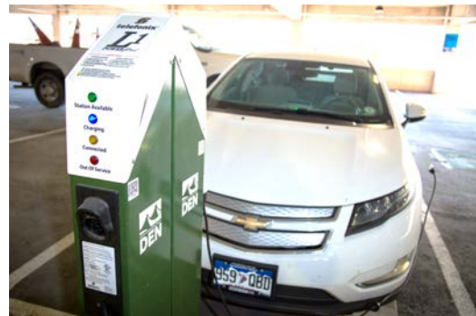
Bornes de recharge à l'aéroport de Denver Source: Aéroport international de Denver
