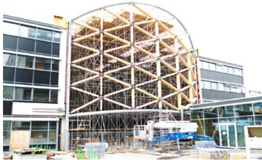
Construction de « The Base », Schiphol © buitingstaalbouw.nl
