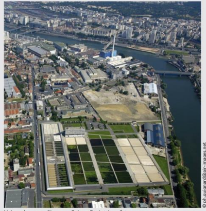
Usines des eaux d'Ivry-sur-Seine - Projet Aquafutura
