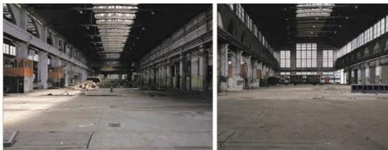
Vue sur l'intérieur de la Grande Halle en direction de l'ouest et de l'est. Le structure est en béton (poteaux-poutres-voûtes) et les grands volumes bénéficient d'un éclairage zénithal. Source des deux photographies : EPA ORSA / Benoît Grimbert
