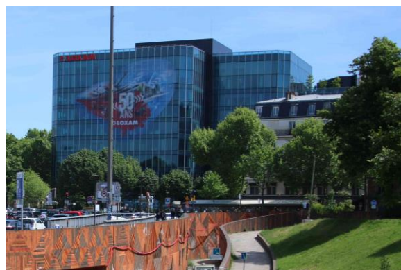
Immeuble de bureaux accueillant le siège de Loxam
