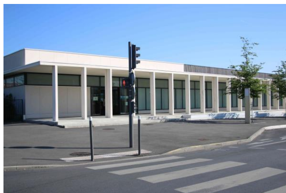
Piscine intercommunale de Houilles
