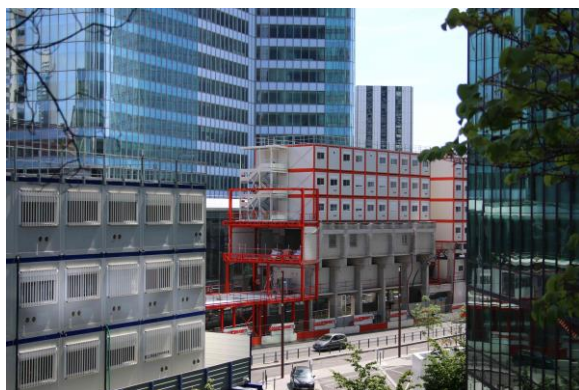
Chantier de la tour Alto
