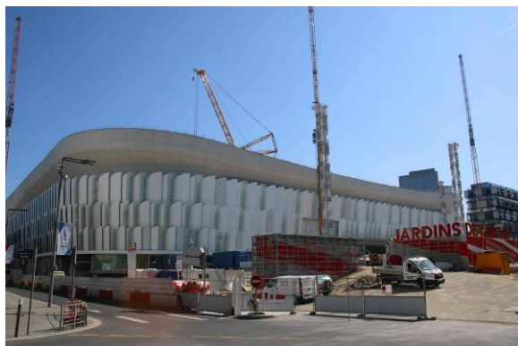
Fin de chantier de l'U Arena
