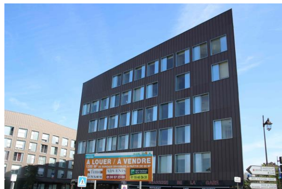
Immeuble de bureaux récent, situé au pied de la gare
