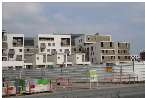
Logements en construction à ZAC Carrières Centralité
