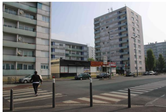
Immeubles d'habitat à proximité de la gare Source : J. Bertrand – IAU idF
