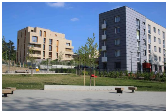
Quartier sud en rénovation urbaine Source : P. Pontecaille – IAU idF
