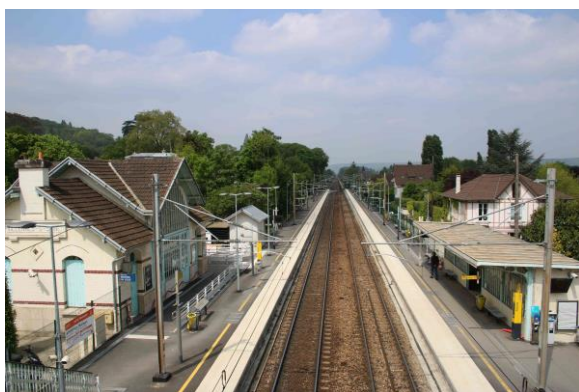
Le bâtiment voyageur et les quais de la gare de Villennes-sur-Seine
