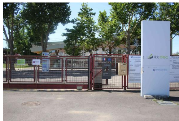
Itedec, école de formations aux métiers du bâtiment
