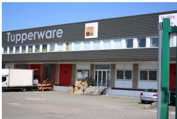
Locaux d'activités logistiques
