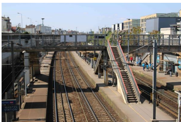
La passerelle d'accès aux quais de la gare de Mantes Station
