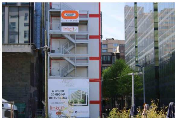
Construction de bureaux accueillant prochainement Groupama Source : P. Pontecaille – IAU idF
