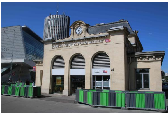
Le bâtiment voyageur de la gare du RER C Neully Porte Maillot
