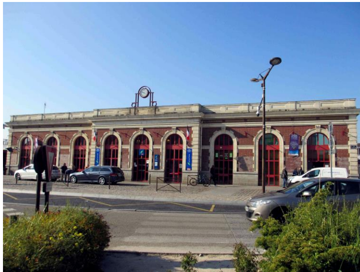
La gare de Mantès-la-Jolie
