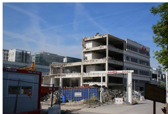
Chantier de démolition d'anciens locaux d'activités Source : P. Pontecaille – IAU idF
