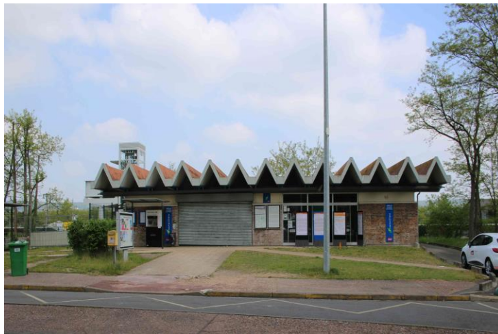
La gare des Clairières de Verneuil
