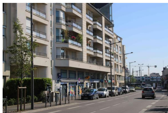
Logements collectifs à Carrières-sur-Seine
