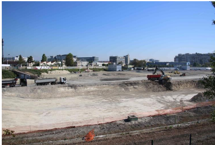
Le chantier de la future gare Eole
