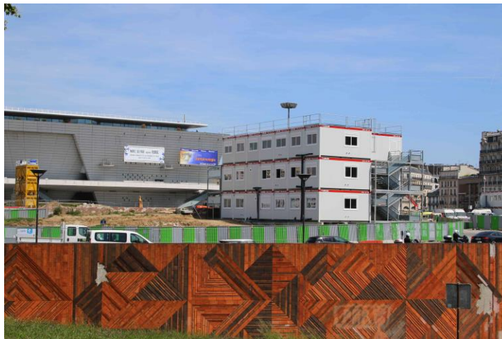
Le chantier de la future gare Eole Neuilly - Porte Maillot
