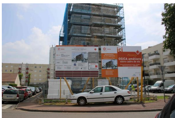
Réhabilitation de la résidence Le Parc à Vernouillet
