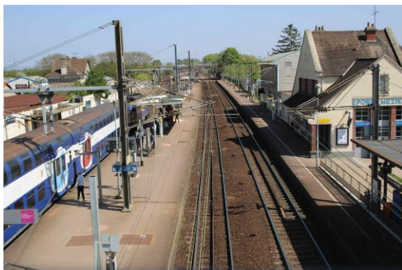
Le bâtiment voyageur et les quais de la gare d'Épône - Mézières
