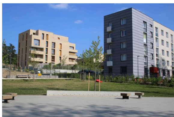
Opération de renouvellement urbain aux Mureaux
