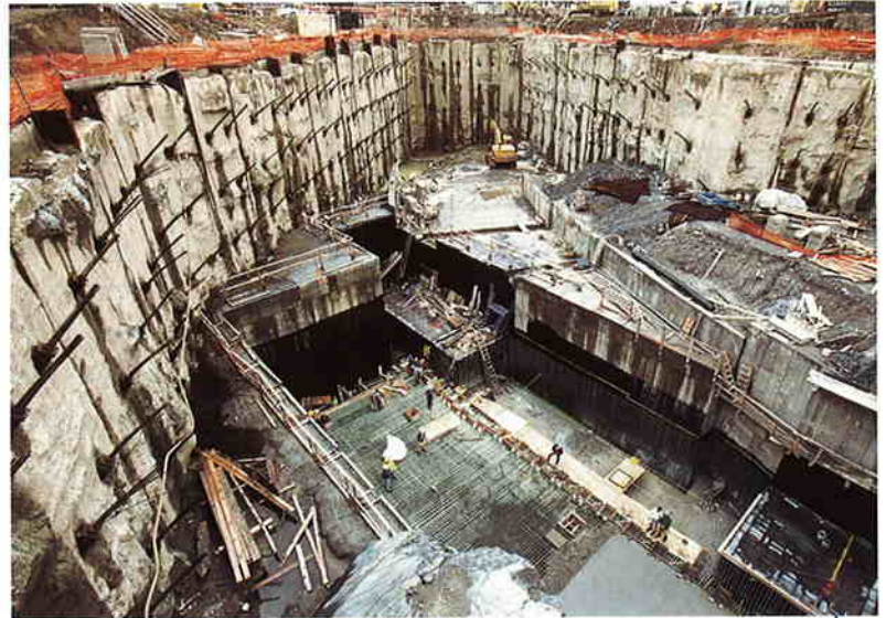
Travaux de creusement pour le 63 e Street Queens Boulevard Connector et début des travaux de construction.
