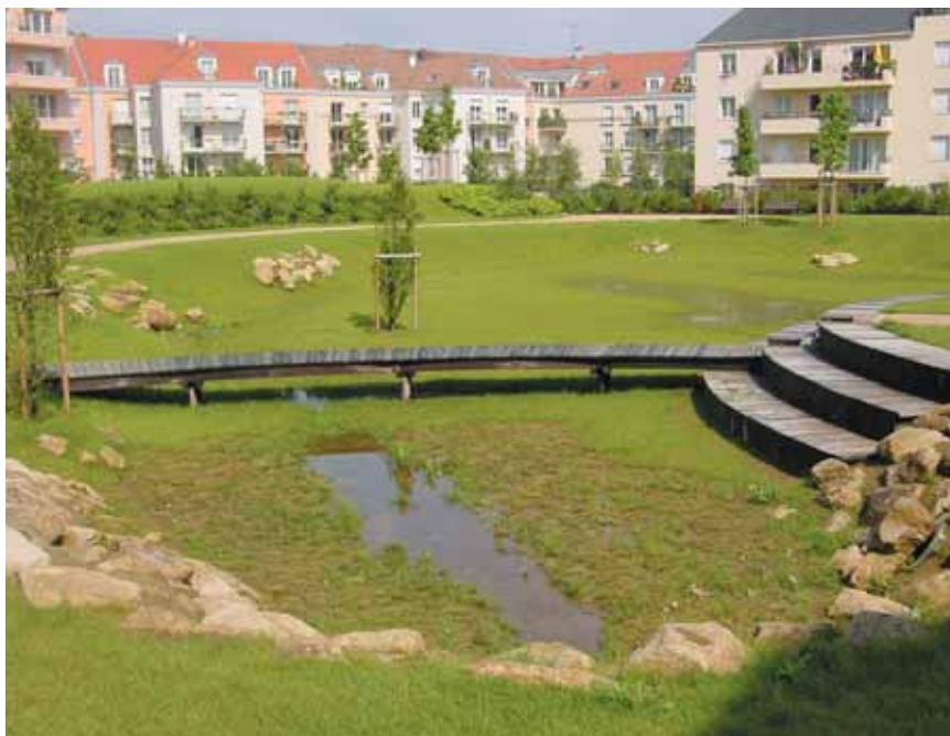
Bassin de rétention dans un parc urbain : le jardin des artistes à Noisy-le-Grand.
