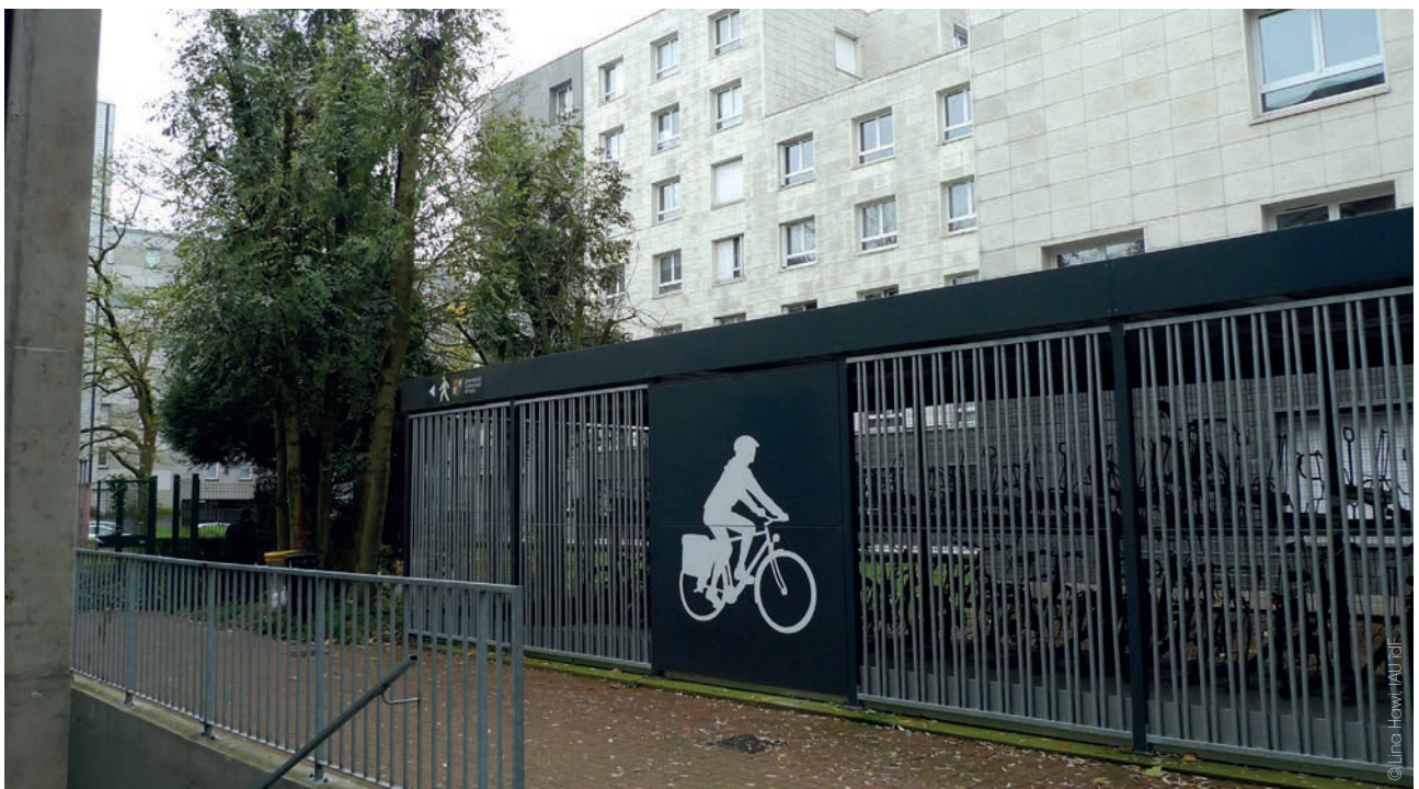
Un garage à vélos sécurisé sur l'un des sites de l'Université Catholique de Lille
