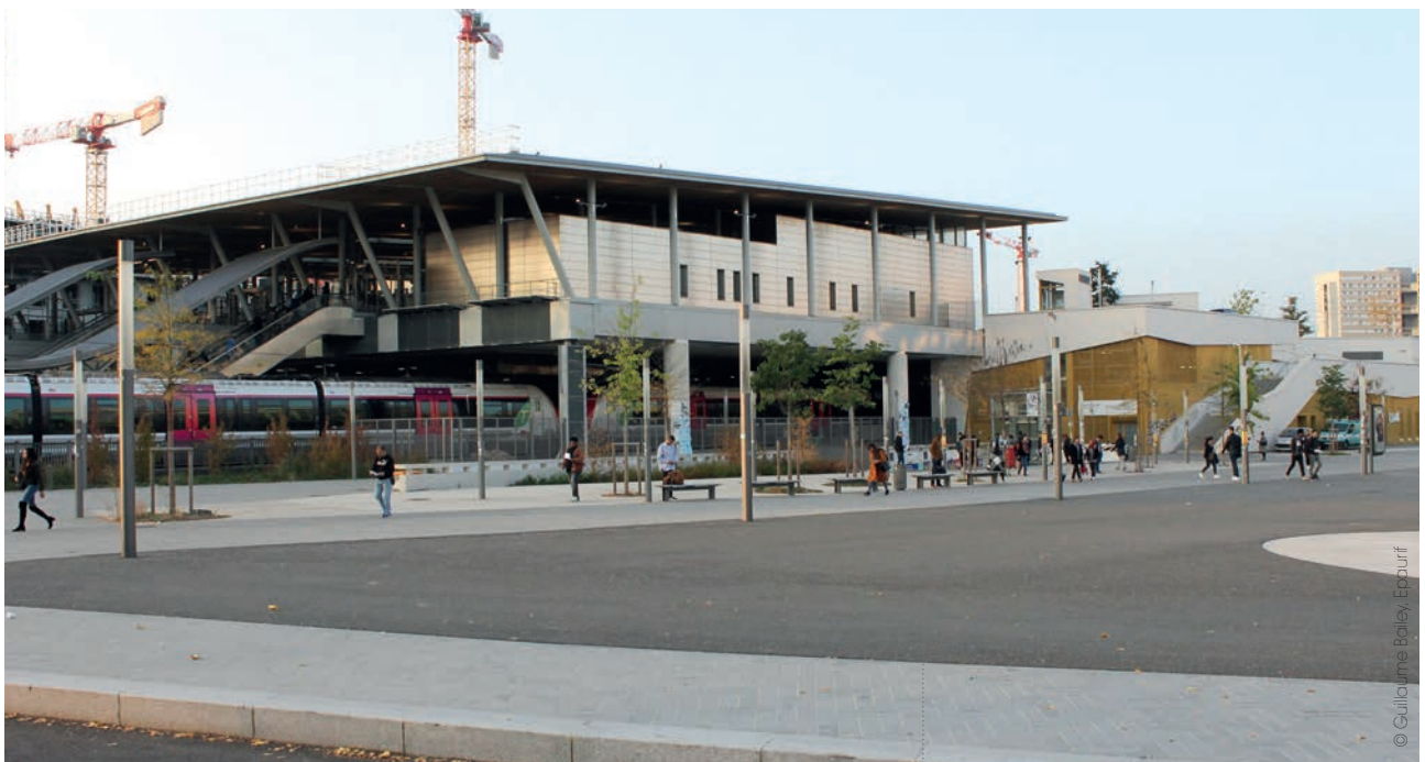
Une nouvelle esplanade et une nouvelle gare pour desservir l'université de Nanterre
