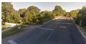
Franchissement du canal de Chelles
