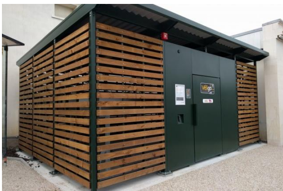
Espace Véligo à la gare d'Étampes © Mairie d'Étampes
