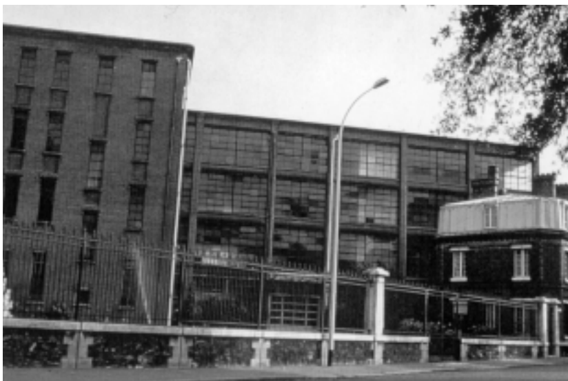
Ancienne manufacture d'œillets métalliques à Ivry (94). Une structure industrielle qui a su s'adapter à la nouvelle fonction culturelle
