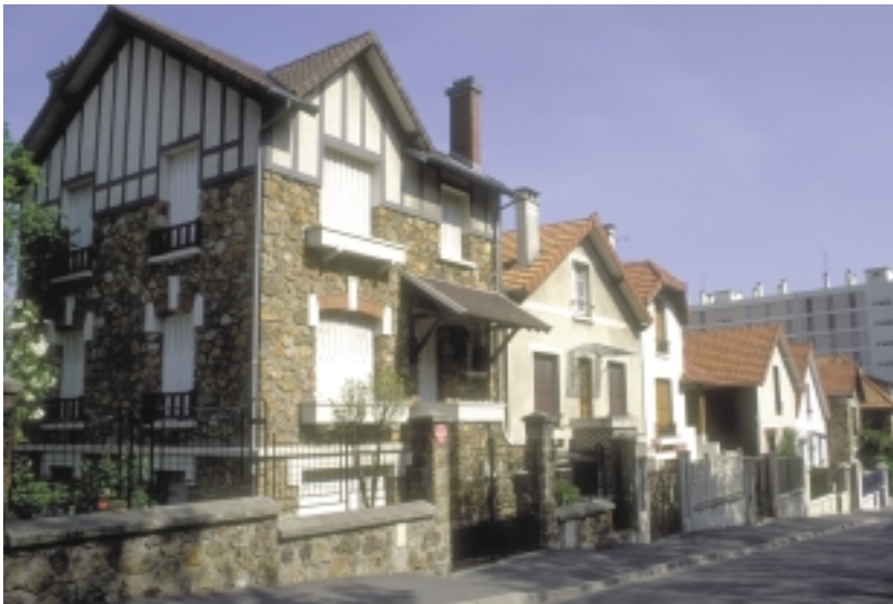
Thiais (94), lotissement pavillonnaire : des matériaux et des formes qui donnent une âme à la ville.
