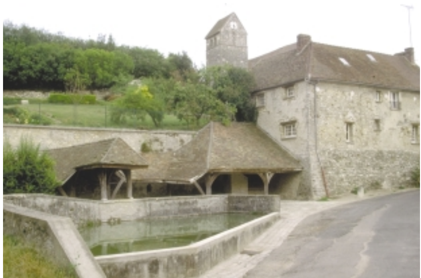
Jumeauville (78). Un ensemble à préserver tout autant que des bâtiments spécifiques
