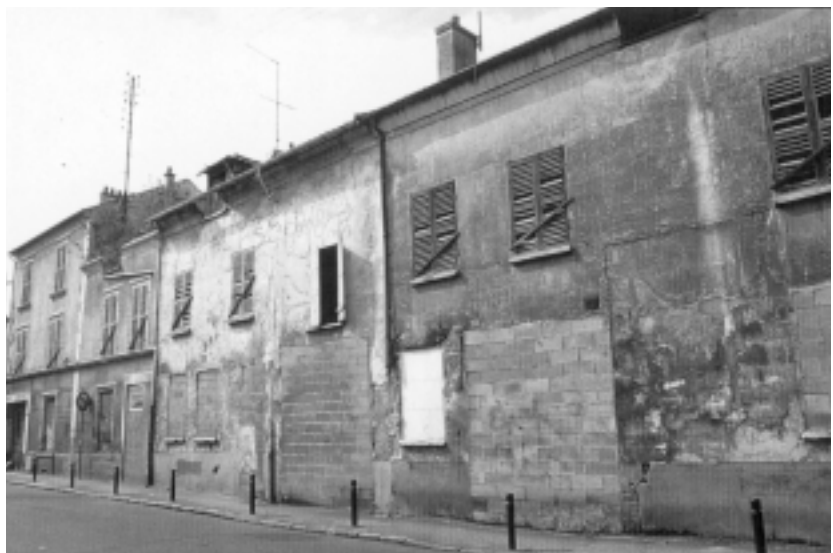
Sartrouville (78), un cœur de village ancien laissé à l'abandon avant sa disparition
