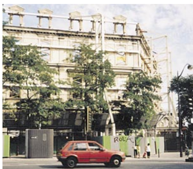
Restructuration d'un immeuble ancien, place Valhubert, Paris 13 ème .
