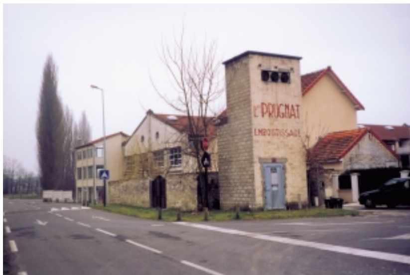
L'exemple d'une friche industrielle partiellement reconverte : à Moret-sur-Loing (77) les anciens établissements PRUGNAT (fabrication de cycles) accueillent le conservatoire du vélo et le centre de l'entreprise.
