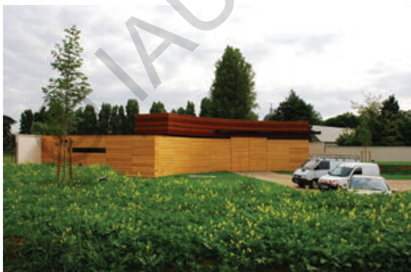
Réservoir de rétention d'eau de pluie, Chevilly-Larue, Val-de-Marne.
