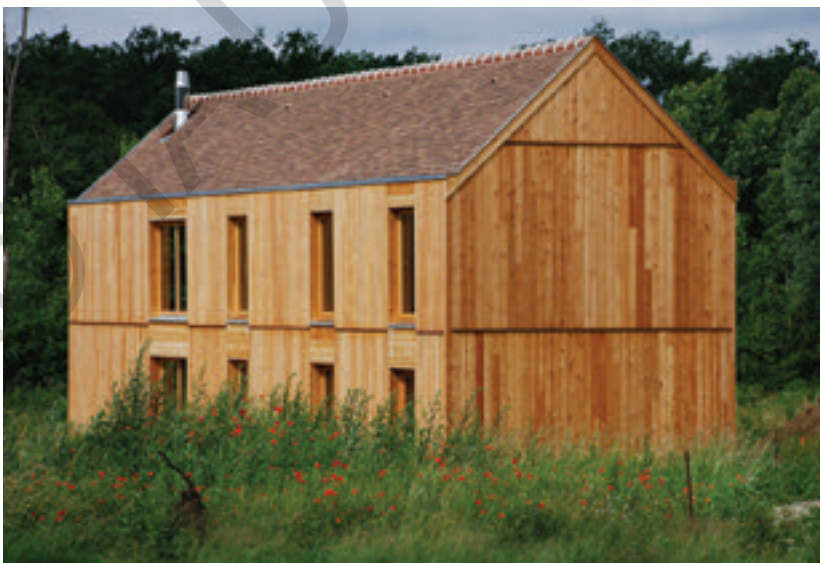
Maison de bois en mélèze, Longvilliers, Yvelines.
