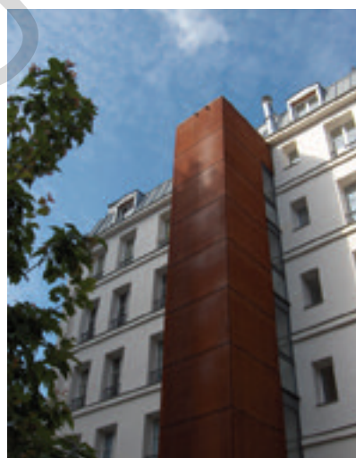
Réhabilitation HQE de logements sociaux, rue Desargues, Paris XI.
