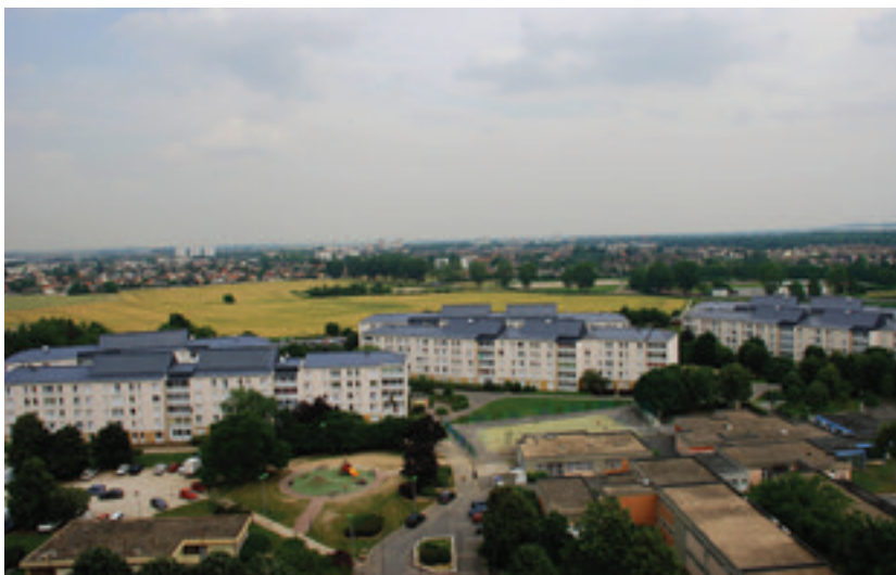
L'évolution spatiale des communes rurales montre l'importance des relations entre densité, compacité et contrainte énergétique. Vue d'ensemble de bâtiments réhabilités par Logirep (850 m 2 de capteurs solaires sur les toits), entourés de champs de blé.
