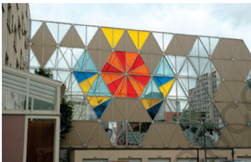
Réhabilitation et résidentialisation avec intégration d'un mur anti-bruit, logements HLM, rue Bédier, Paris XIII e .
