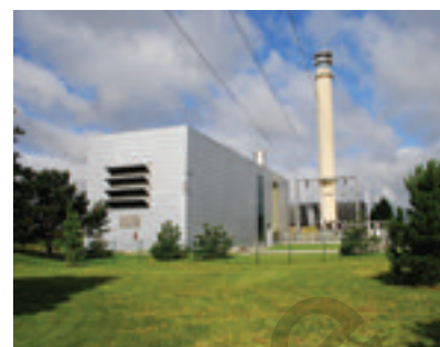
Usine de cogénération, Thermulis, Les Ulis, Essonne.
