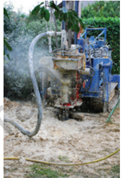
Géothermie verticale dans du calcaire poreux de bord de Seine, Champagne-sur-Seine, Seine-et-Marne.
