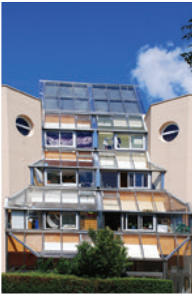
La forme urbaine (enveloppe et orientation) est un des leviers disponibles pour réduire les consommations d'énergie. Immeubles de la fin des années 1970, en solaire collectif et verrières, rue Beethoven, Guyancourt, Yvelines.
