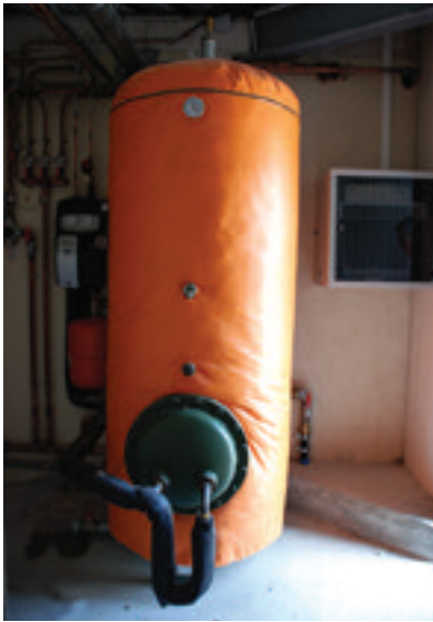
Ballon tampon relié aux capteurs pour eau chaude sanitaire, Syndicat intercommunal vallée de l'Essonne.
