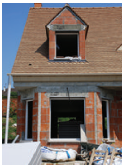
Maison en briques alvéolaires avec un doublage placo doublissimo Lafarge, Saint-Rémy-les-Chevreuse, Yvelines.
