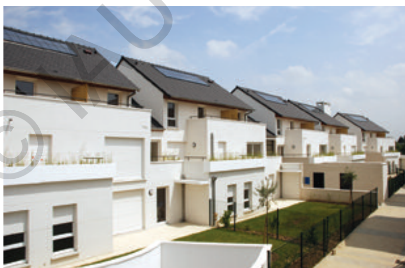
Lotissement de vingt-sept logements équipés de capteurs solaires thermiques et photovoltaïques, Montigny-le-Bretonneux, Yvelines.
