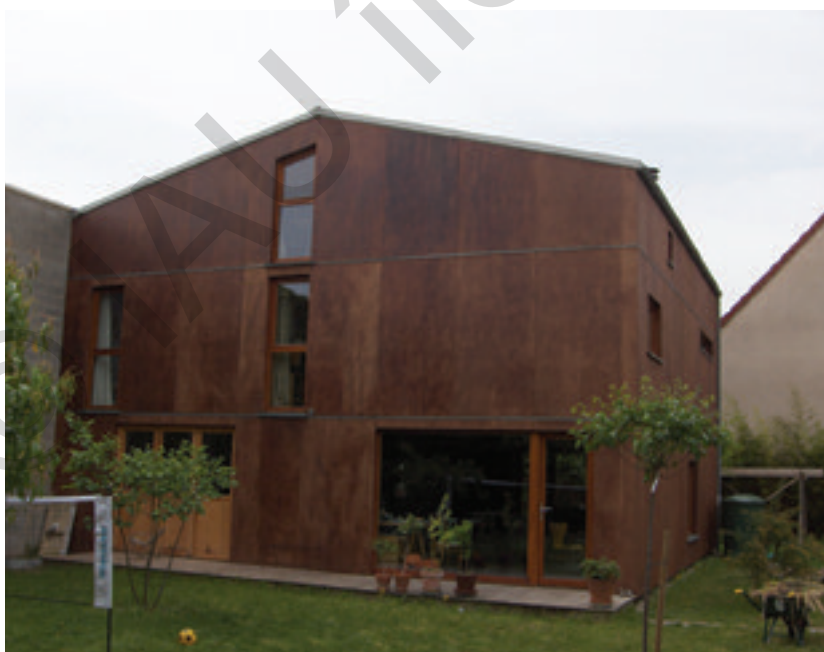
Transformation d'un ancien entrepôt en maison d'habitation avec démarche HQE, Montreuil, Seine-Saint-Denis.
