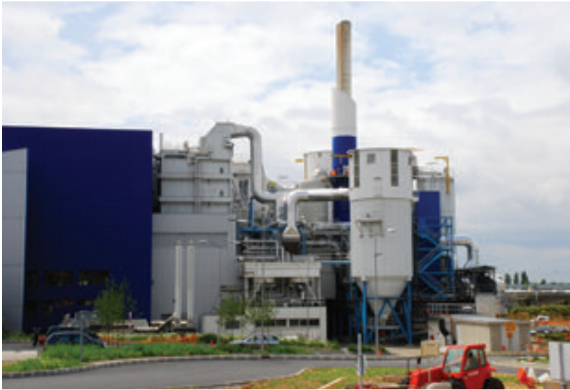
Incinérateur chauffant la zone d'activité de Courtabœuf (72 000 tonnes brûlées pour 39 000 Mwh d'eau chaude), Les Ulis, Essonne.
