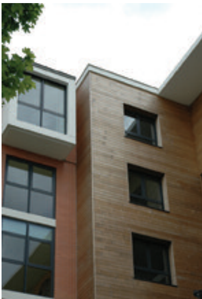
Résidence pour personnes âgées intégrant des matériaux non toxiques et des capteurs solaires sur le toit, Hérol, Paris XIX e .
