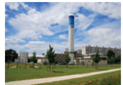
Chauffage urbain par la géothermie, STHAL, Melun, Seine-et-Marne.
