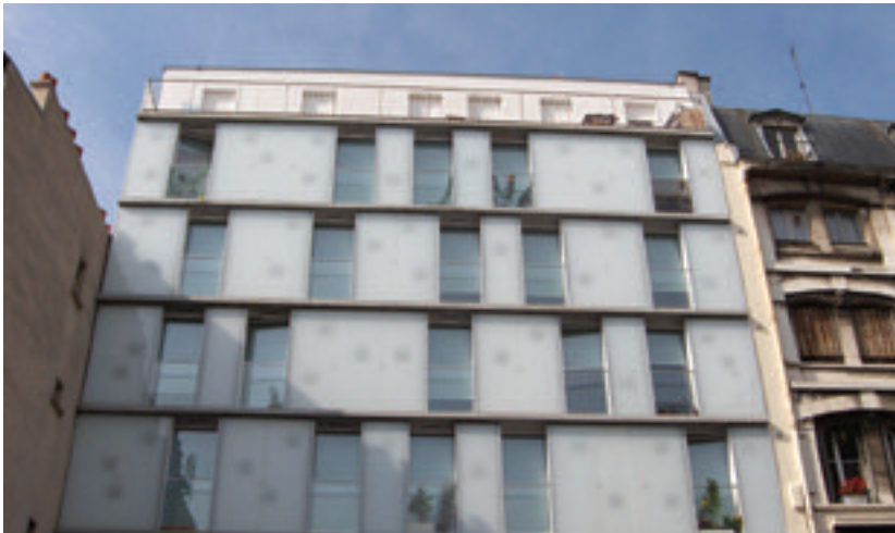
Construction de dix-sept logements «habitat et environnement», rue Louis Blanc, Paris Xe.
