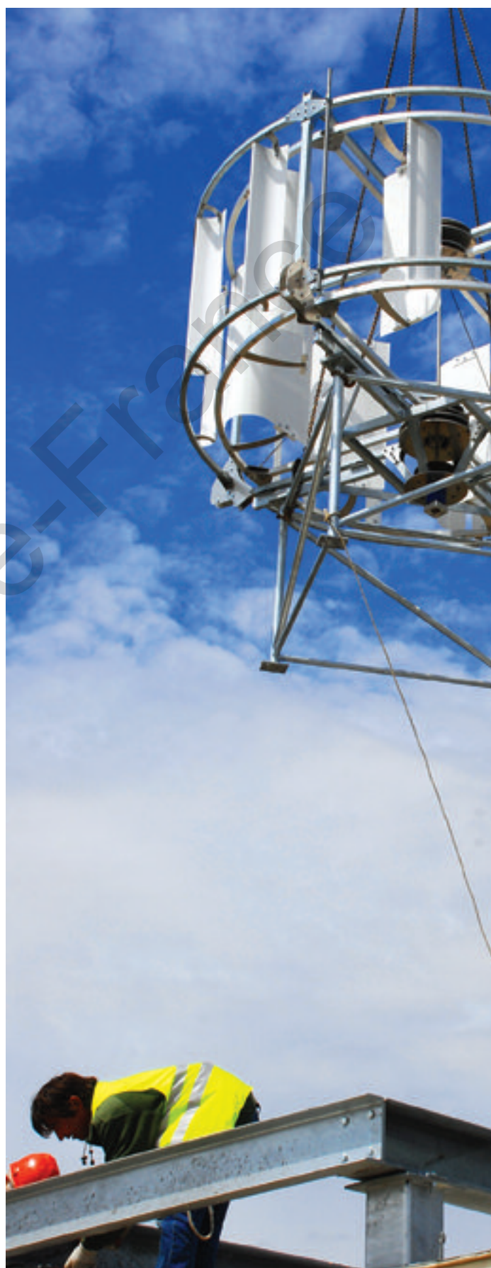
B. Raoux/Iaurif - Pose d'une éolienne sur le toit d'un immeuble collectif (Opac de Paris), Val-de-Marne.
