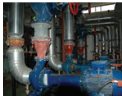
Un système de géothermie, alimentant 300 logements, Tremblay-en-France, Seine-Saint-Denis.
