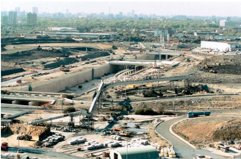
Le chantier de la nouvelle ligne de train à grande vitesse à Stratford (Londres) en 2003.
