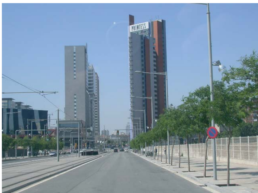
Critiqué pour son «élitisme», le projet a sans doute contribué à hisser Barcelone au 4 e rang des «villes où investir» (selon European Cities Monitor 2006). Ici l'hôtel Princess et le tramway.
