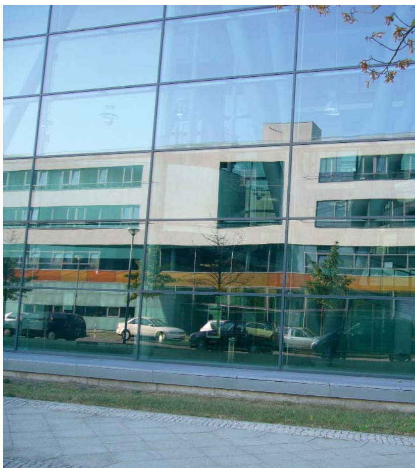
Adlershof, projet de technopole urbaine longtemps porté à bouts de bras par le secteur public dans des conditions difficiles, a aujourd'hui une dynamique économique propre. Ici bâtiments de l'université von Humbolt.
