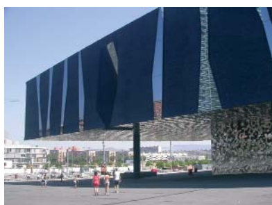
L'édifice phare du projet, le Forum, est tout à la fois un bâtiment et une place publique.
