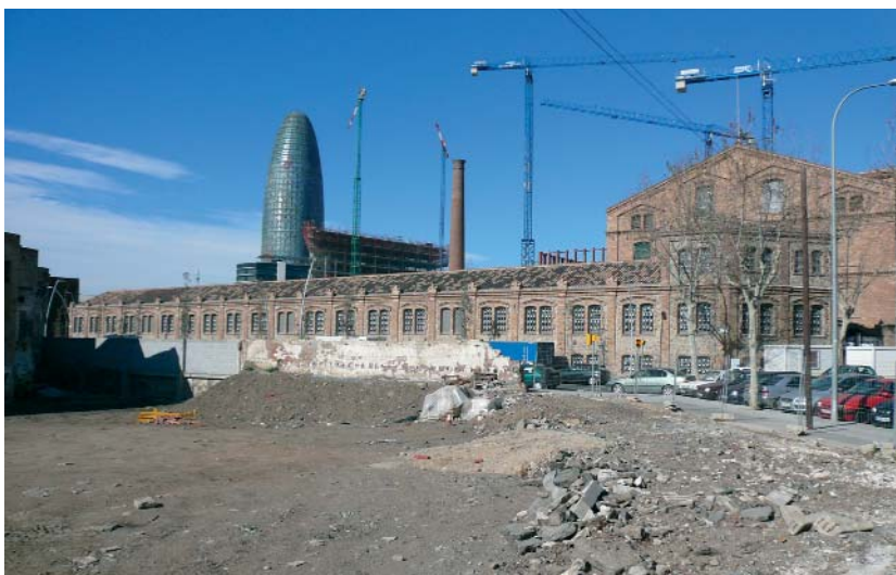
La préservation du patrimoine industriel commence à être intégrée au projet 22@. L'ancienne usine Ca l'Arano accueillera l'université Pompeu Fabra.
