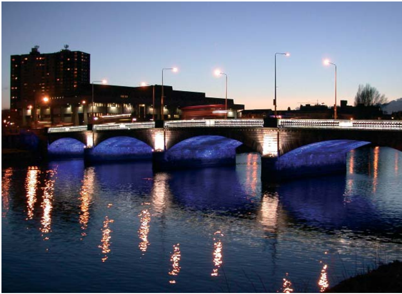
La mise en lumière des ponts crée un événement dans les sites en attente d'aménagement.
