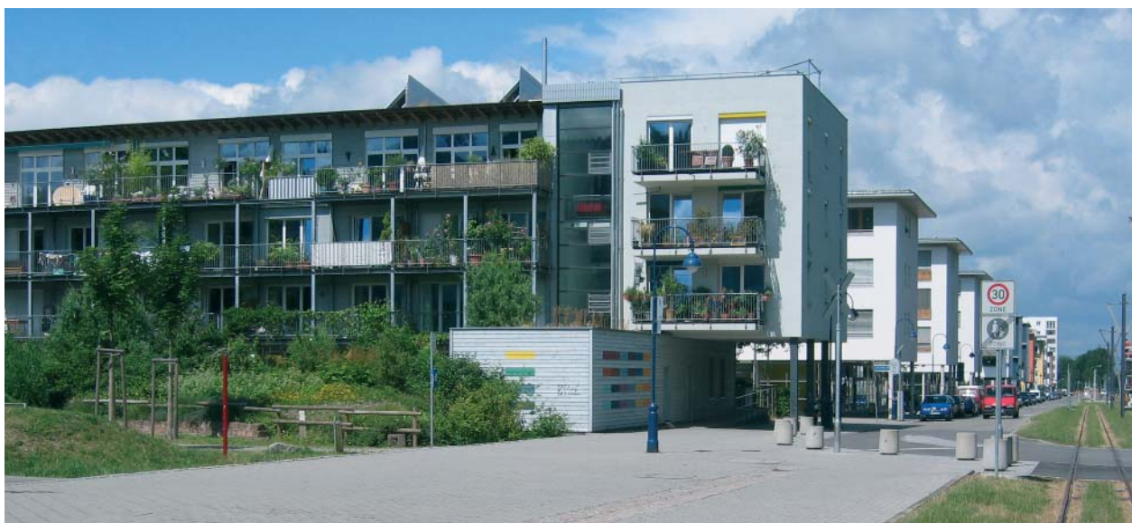
À Vauban, les logements consomment peu d'énergie (<65 KW/m 2 /an). Le stationnement est regroupé en limite de quartier dans trois parkings-silos et, grâce au tramway, un quart des ménages se sont engagés à renoncer à la voiture.
