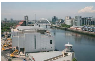
Vue du Scottish Exhibition Center (SECC) depuis Lancefield Quay.
