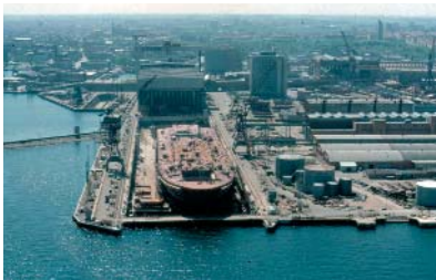
L'occupation initiale du site, les chantiers navals de Kockum.
