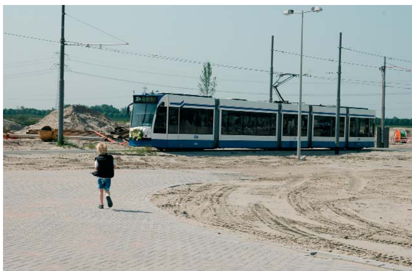
Le nouveau tramway rapide, inauguré en mai 2005, relie IJburg à la gare centrale en dix minutes avec une fréquence de l'ordre du quart d'heure.
