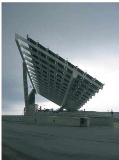
La centrale photovoltaïque sur l'esplanade du Forum : l'approche environnementale a été intégrée dès l'origine au projet.
