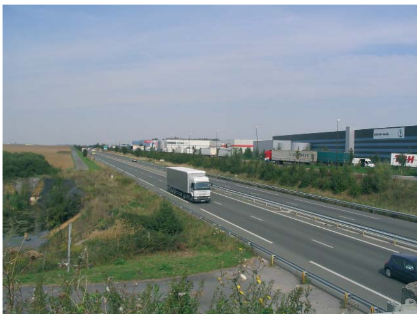
Zones d'activités de Lagny-le-sec et du Plessis-Pâté (Oise) le long de la RN2 : exemple de mouvement de desserrement des entreprises vers des départements limitrophes de la région d'Île-de-France.
