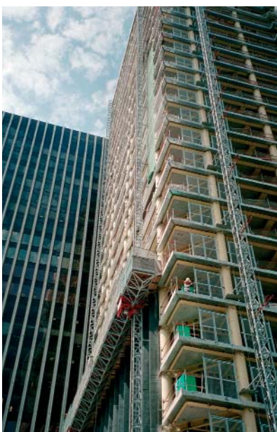
La construction de bureaux prend son essor dans les années 1970 avec une génération de tours au gabarit imposant comme la tour BP 12 à La Défense, érigée en 1973 et récemment restructurée.
