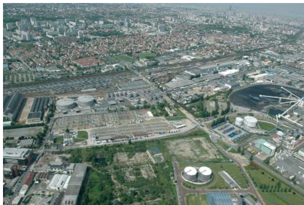
Vue aérienne de la ZAE «des Ardoines», dont la requalification est soutenue par la Région à hauteur de 25 %.
