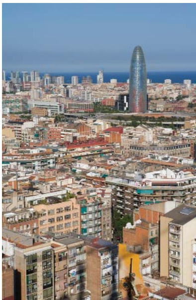
La Torre Agbar (144 m), inaugurée en 2005, domine le futur pôle d'affaires et d'activités de pointe de 22@ à Barcelone.
