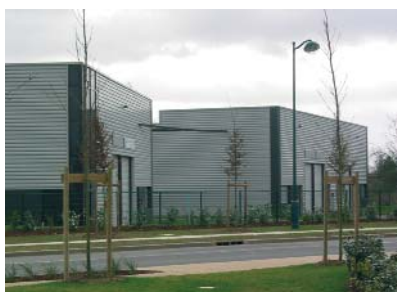
Construction d'ateliers locatifs artisanaux à Bailly-Romainvilliers, soutenue par le SAN du Val d'Europe, la Région, le département et les villes.
