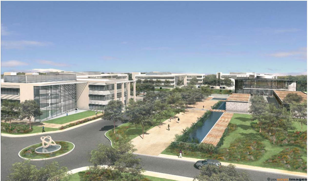
Exemple de parc d'activités tertiaire d'une superficie de 77 000 m 2 de bâtiments, développé selon le concept d'«Office Park» international par le promoteur Akeler à Wissous.
