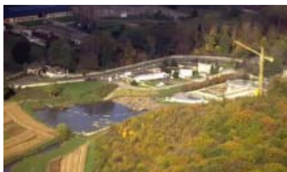
© H. Raguet – IAURIF. Station d'épuration en travaux à Rambouillet
