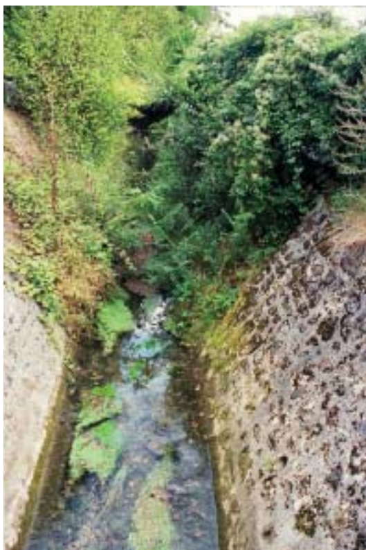
© M. Pruvost-Bouvattier – IAURIF – Rivière canalisée
