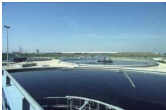
© M. Vergnolle – IAURIF. Station d'épuration de Valenton
