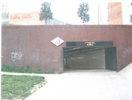
Ouverture d'une station de métro dans le grand ensemble de Trinitat Nova. © laurif
