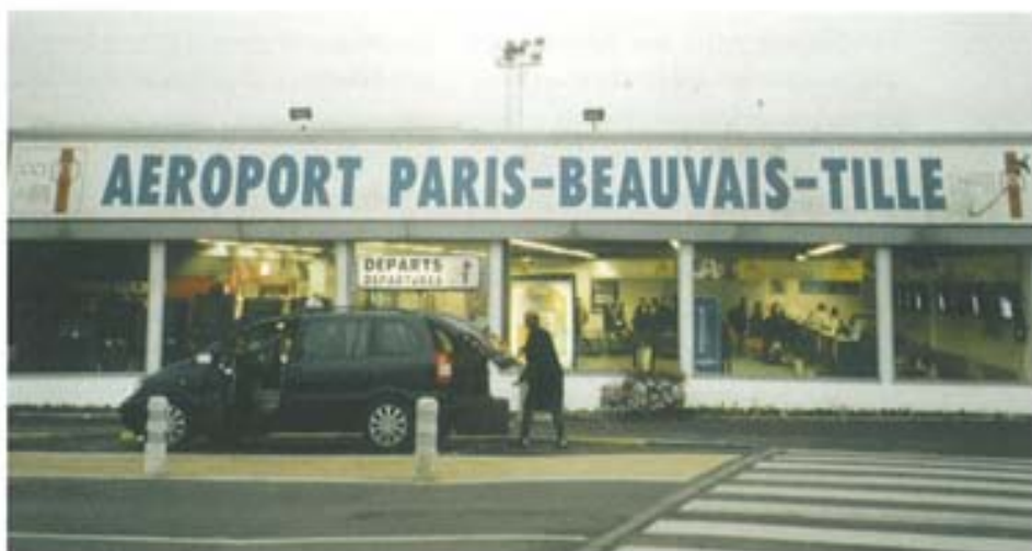
Des installations modestes pour du trafic low-cost É. Bohan/MORF
