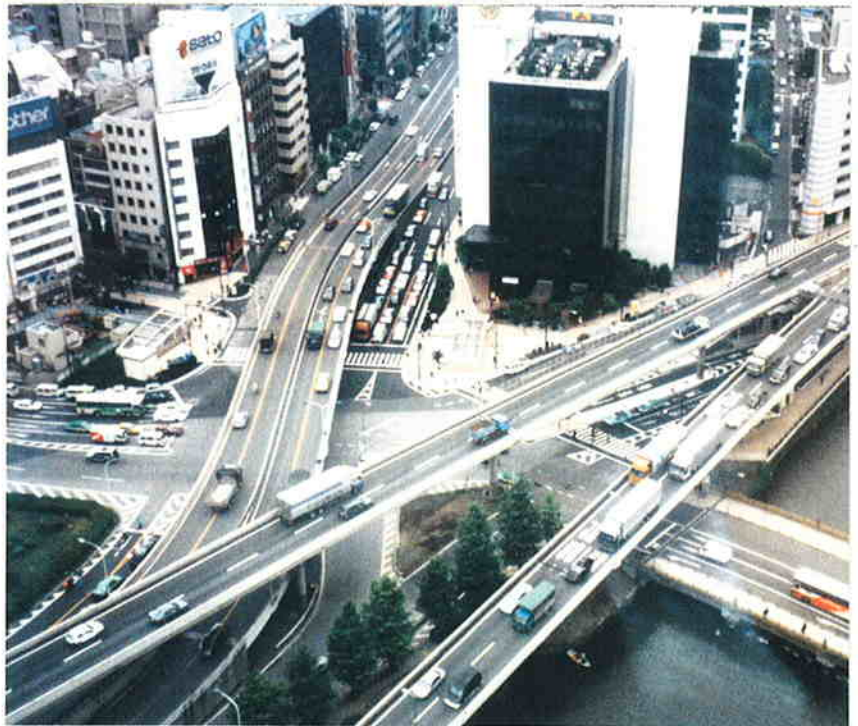
Les camions sur le viaduc de la Metropolitan Expressway vont vers le port de Tokyo
