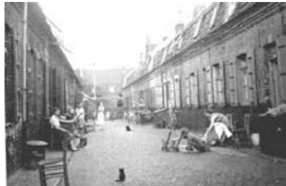
© - Photo tirée d'un rapport sur l'insalubrité à Roubaix vers 1950 - Médiathèque municipale de Roubaix - cl. Paul Povoas - http://asso.nordnet.fr/vandermeersch/expo/courees
