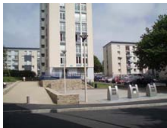
©Volkwein IAURIF, transformation de l'accessibilité à la tour, création d'espaces publics de qualité, mise en place de conteneur enterrés pour palier au risque de feux de poubelles.
