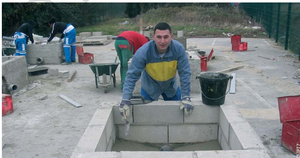
Un jeune en train de monter une cunette assainissement hors sol dans le cadre de la formation «maçon VRD».
