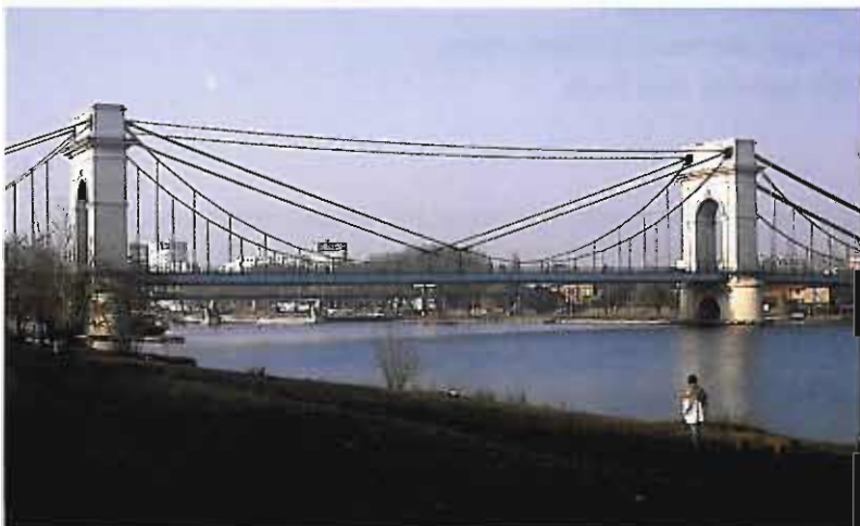
Pont du Port-à-l'Anglais sur la Seine entre Vitry et Alfortville.
