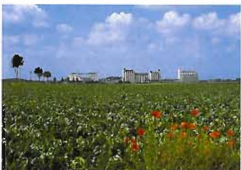
Silos à Verneuil-l'Étang.
