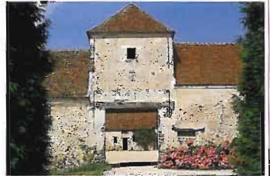
Ferme à Aulnoy, près de Coulommiers.
