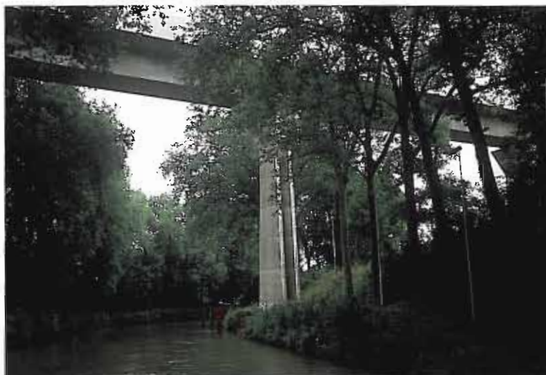
Le passage des infrastructures sur des ouvrages d'art plutôt qu'en remblai permet de maintenir les continuités biologiques, fonctionnelles et visuelles.
