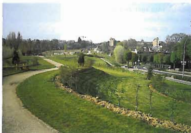
Passage du TGV en tunnel à Sceaux et Châtigny-Malabry, avec aménagement d'un véritable parc urbain en surface.
