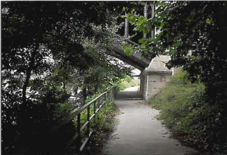
Assurer la continuité des cheminements le long des cours d'eau...
