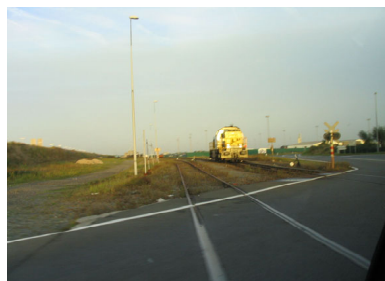
Embranchement ferroviaire pour la zone logistique dédiée au trafic automobile
