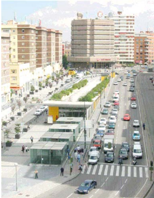
Vue extérieure du pôle Avenida de America en 2000 (Photo CRTM)
