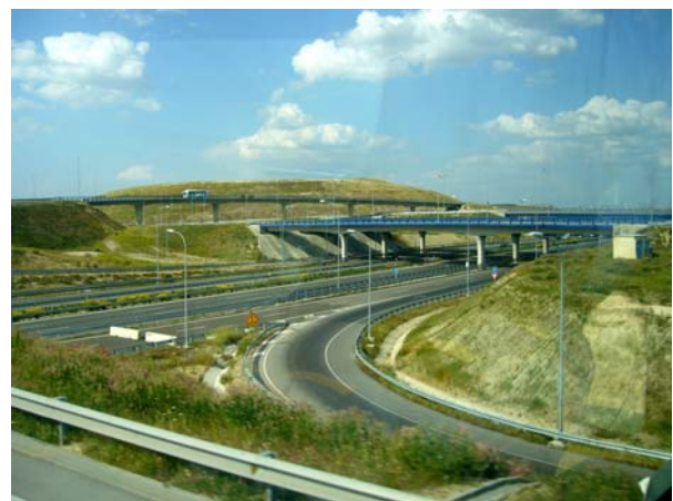
Echangeur entre la M 45 et la M 31
