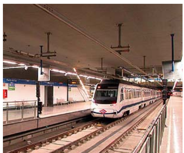
Rame à quai à la station Puerta del sur
