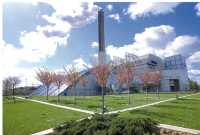
Le centre multifonctionnel de traitement des déchets ménagers du SYCTOM de l'agglomération parisienne à Saint-Ouen / Seine-Saint-Denis.
