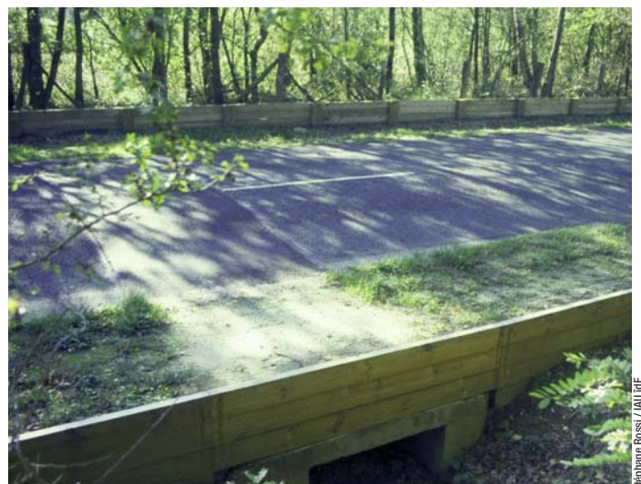
Les « crapauducs » permettent la traversée en tunnel des animaux.
