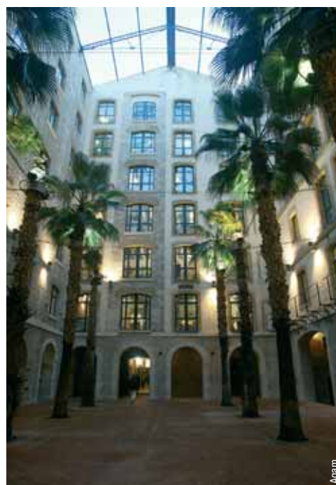
Euromed réaménagement des Docks
