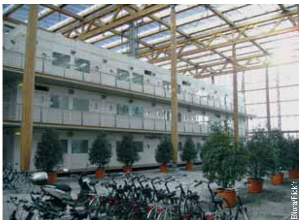
Réhabilitation d'un bâtiment industriel
