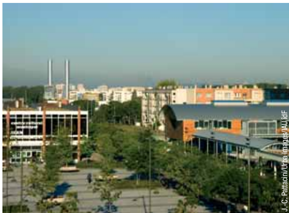
Aménagement des espaces libérés par la démolition des barres
