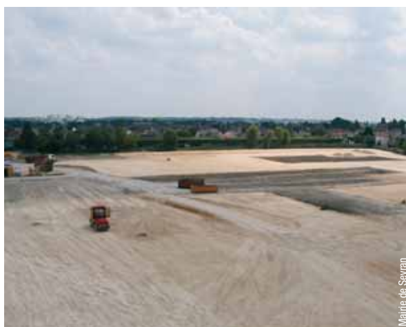
Le site Kodak après démolition
