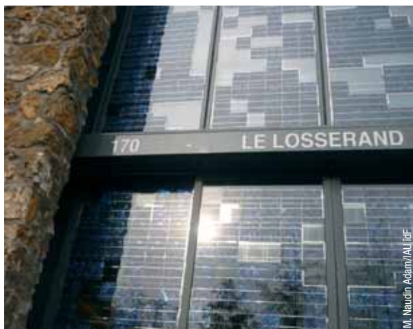
Façade à cellules photovoltaïques
