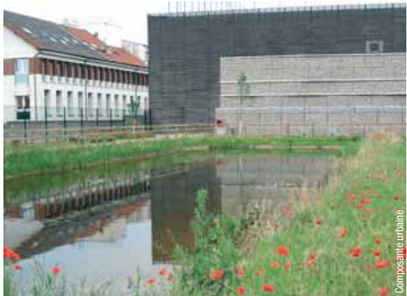
Système de bassins permettant la maîtrise et la dépollution des eaux pluviales
