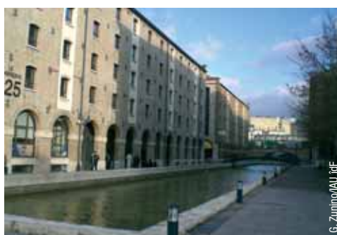
Locaux industriels transformés en bureaux
