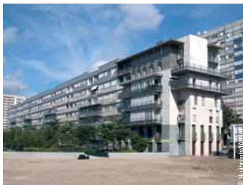
Rénovation urbaine d'habitat social
