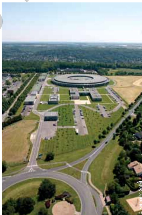
Le Synchrotron Soleil, inauguré en 2006 près de Saclay (91), symbole de l'économie du savoir.
