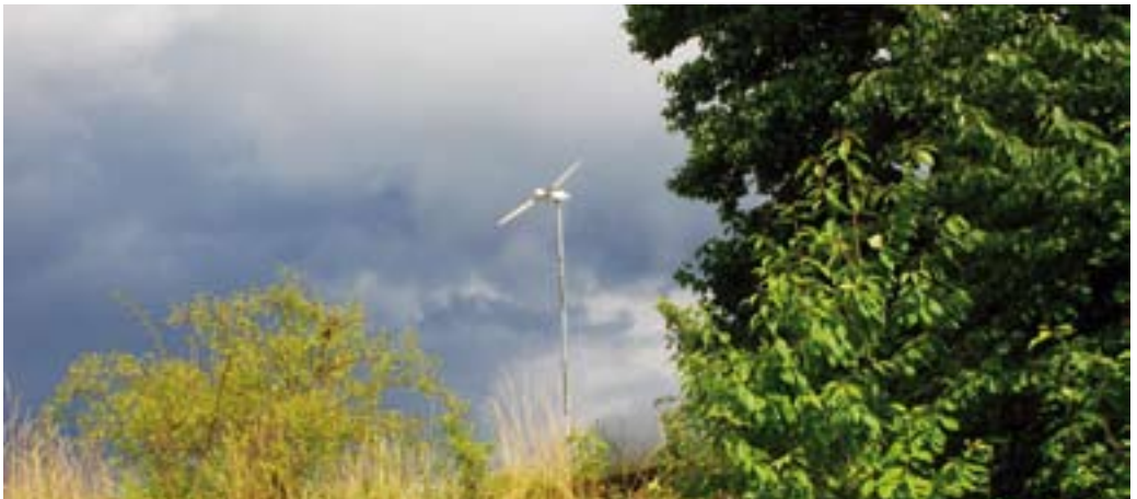
Éolienne alimentant un centre de stockage de déchets ultimes (78)
