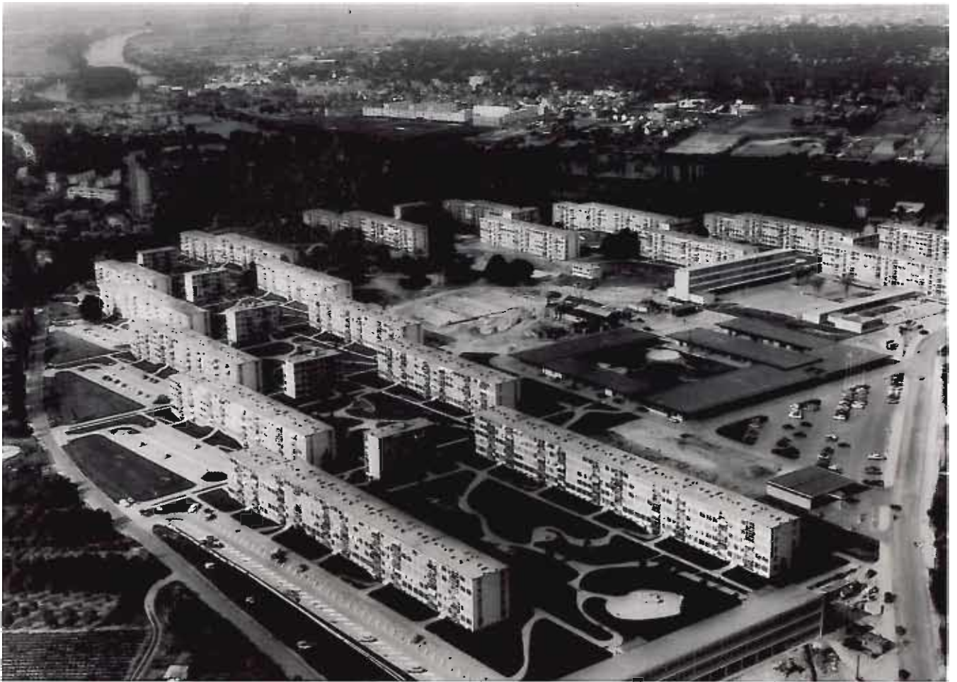
Les Grandes Terres à Marly-le-Roi. La Charte d'Athènes a engendré de nouvelles formes qui ont nié tout héritage du passé : les opérations, suivant l'orientation solaire, ne se sont plus inscrites dans la parcellaire et dans les sites, tournant parfois le dos aux vues, aux villes...
