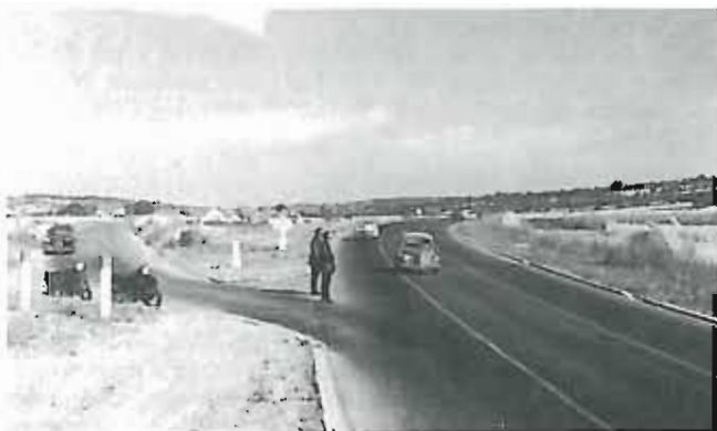
La déviation d'Ecquevilly peu après son ouverture.
