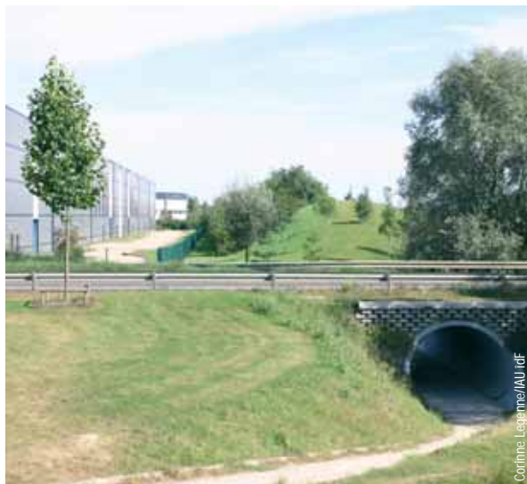
Le passage piéton assure la liaison vers le quartier « la Haie fleurie »
