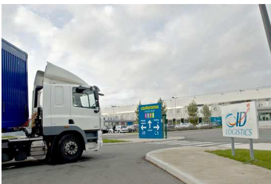
L'entrée du parc logistique de Val Bréon, sur la N4 (Île-de-France)
