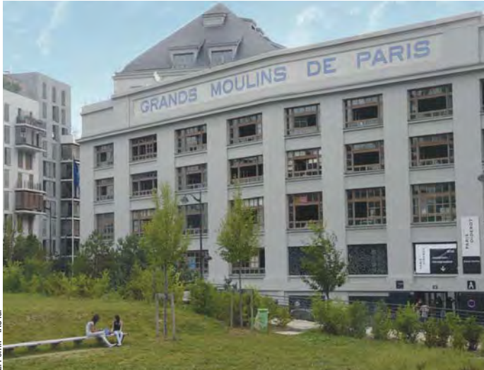
Bâtiment des Grands moulins de Paris accueillant les services centraux de l'université Paris VII.
