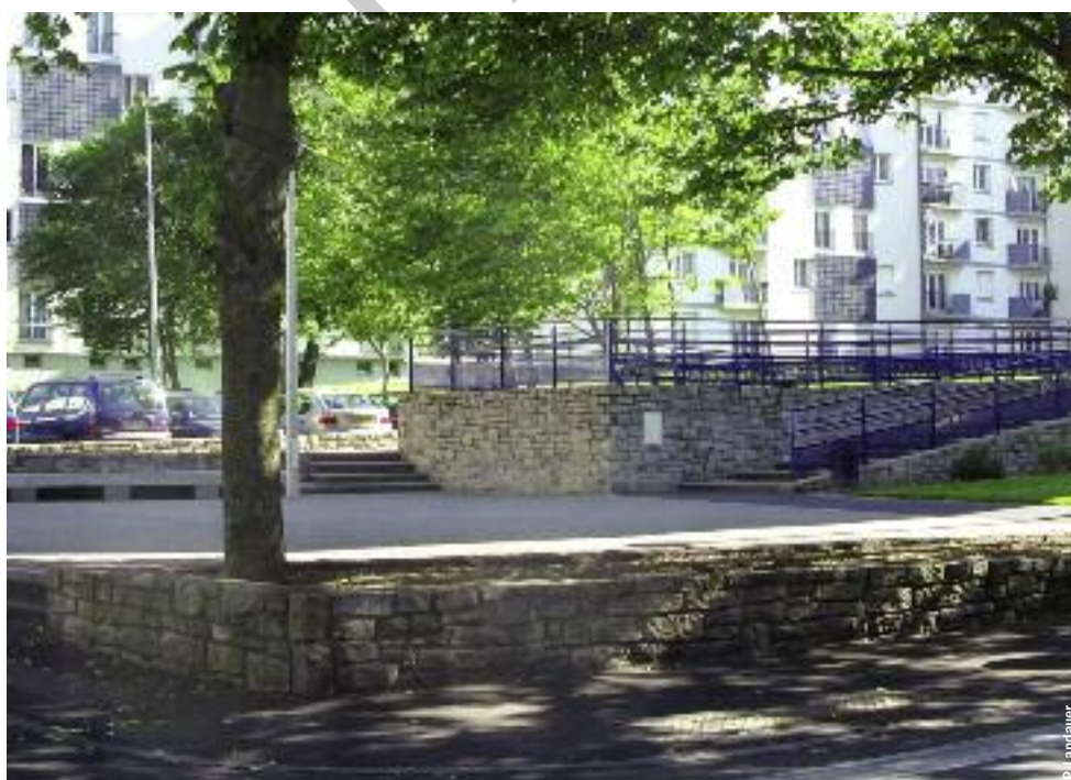
Création d'une place dans le cadre de l'opération de sécurisation d'un quartier d'habitat social à Brest.
