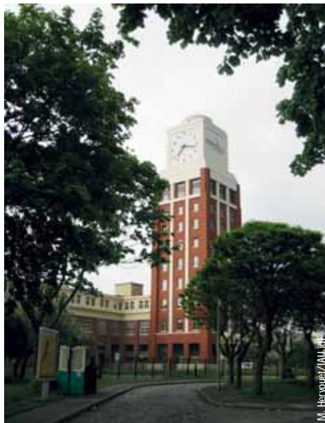
Bâtiment de l'ancienne imprimerie de L'illustration réhabilité par l'université Paris 13 à Bobigny.
