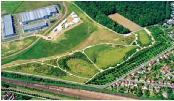
Au 1 er plan, le Parc de la Borne Blanche, une coupure verte entre le parc d'activités et le quartier résidentiel de Combs-la-Ville
