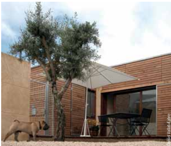
Façade intérieure sur le patio
