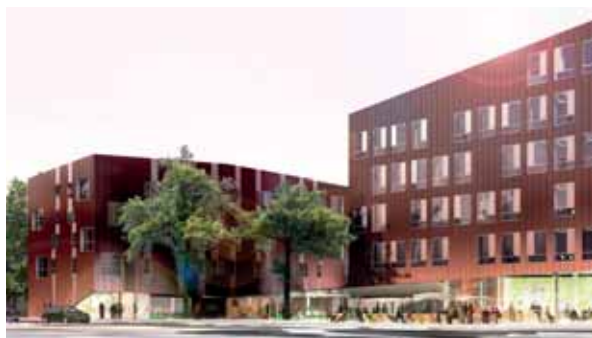
ENM, agence Hauvette, îlot comprenant des logements, des bureaux, une crèche et des commerces
