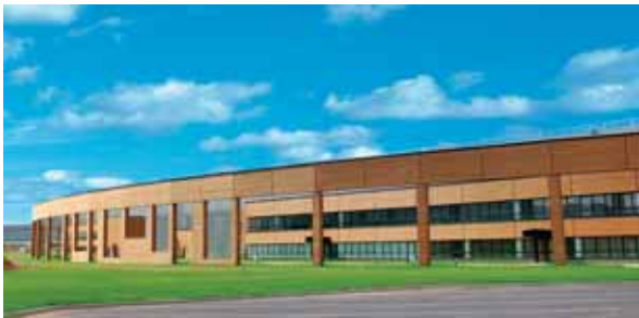
Les entreprises sont soumises à une charte de qualité environnementale pour leur construction. Parc de la Borne Blanche, façade de la société Samada
