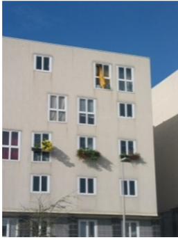
Résidence Rimbaud, Orly Parc
