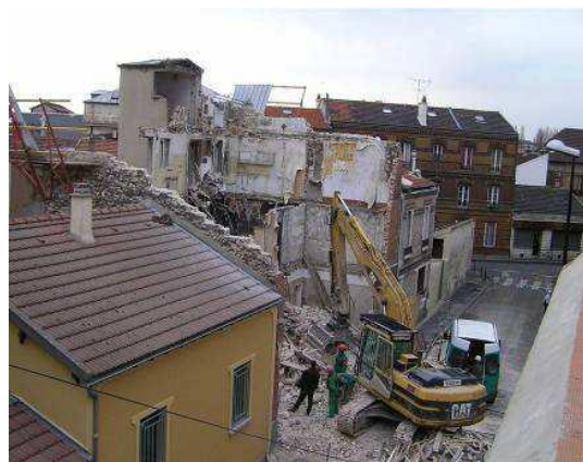
Source : Convention PNRQAD d'Aubervilliers Démolition du 15 rue du Colonel Fabien
