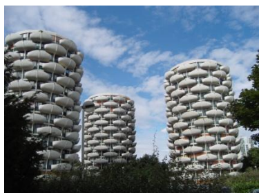
Les choux de Créteil
