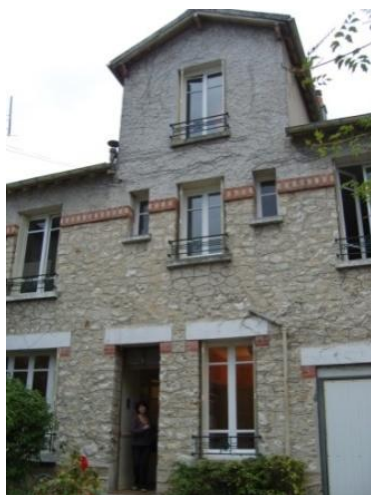
Façade de la Maison de la Famille Crédit photo : V. Malochet/IAU îdF
