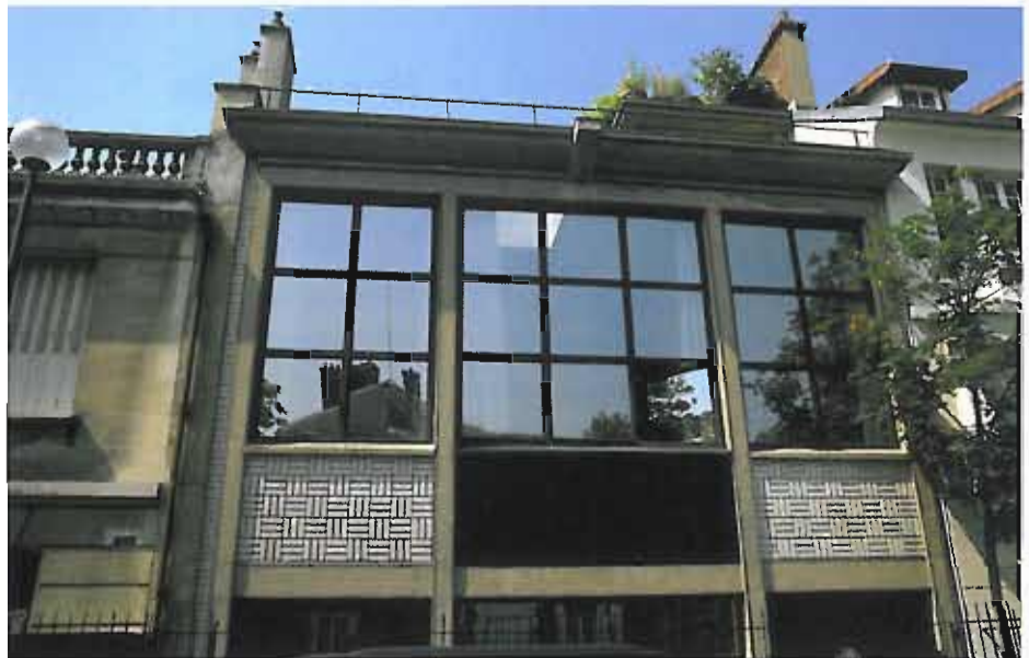
Atelier Dora Gordine à Boulogne-Billancourt (92). Architectes : A. et G. Perret - 1929
