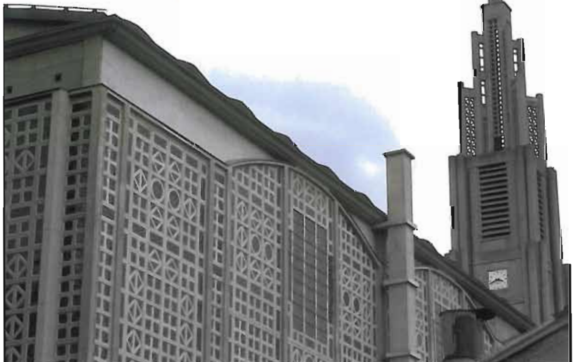
L'église Notre-Dame de la Consolation au Raincy (93). Architectes : A. et G. Perret (1923). B. Gegauff/laurif
