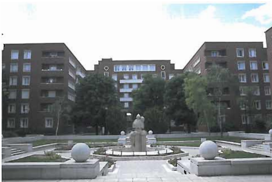
Groupe d'HBM, square Maurice-Dufournantelle à Maisons-Alfort (94). Architectes : A. Dubreuil, R. Hummel B. Gegauff/Aurif
