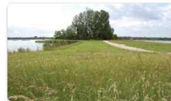
Réaménagement à vocation écologique d'une carrière de granulats à Jaulnes (77).
