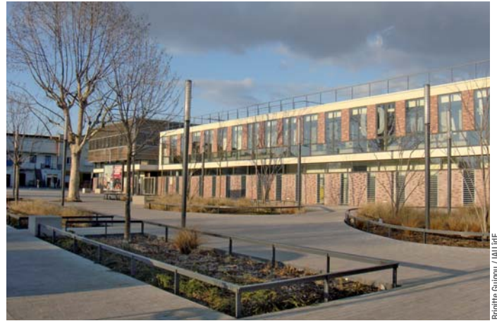
Dans le secteur du Clos Saint-Lazare à Stains (93), la CA contribue à renouveler l'offre d'équipements et à désenclaver le quartier.
