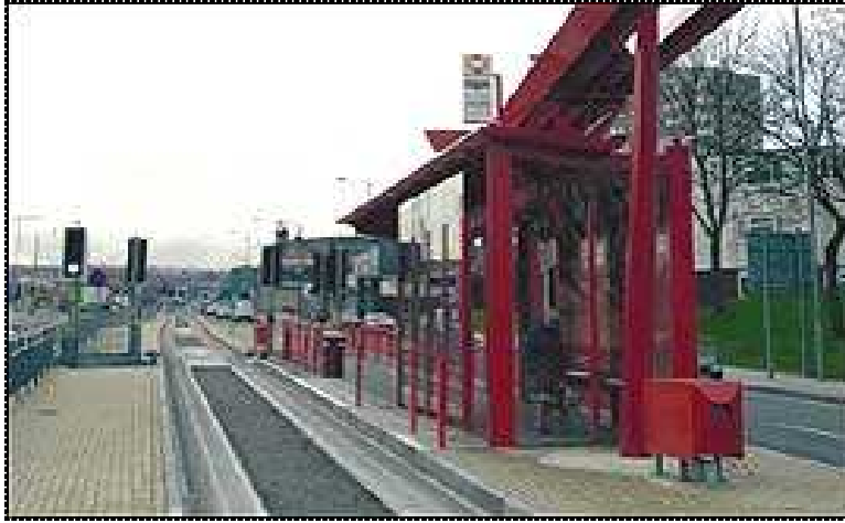
Station de Superbus à la périphérie de Leeds
