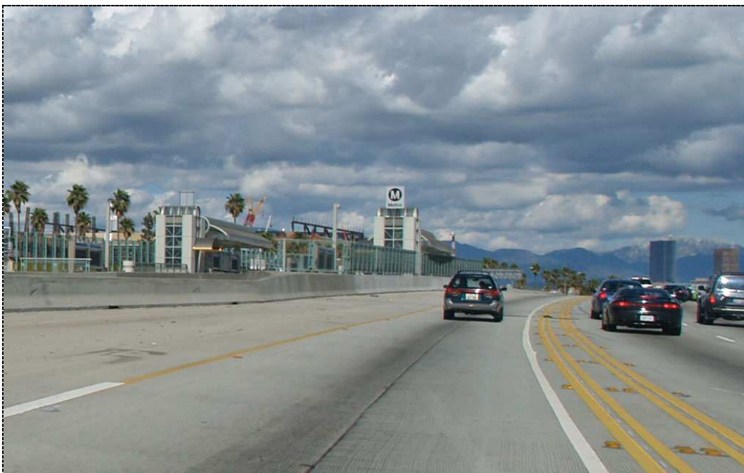
« Harbour Transitway » à Los Angeles : voies centrales réservées aux autobus et aux covoitureurs.
