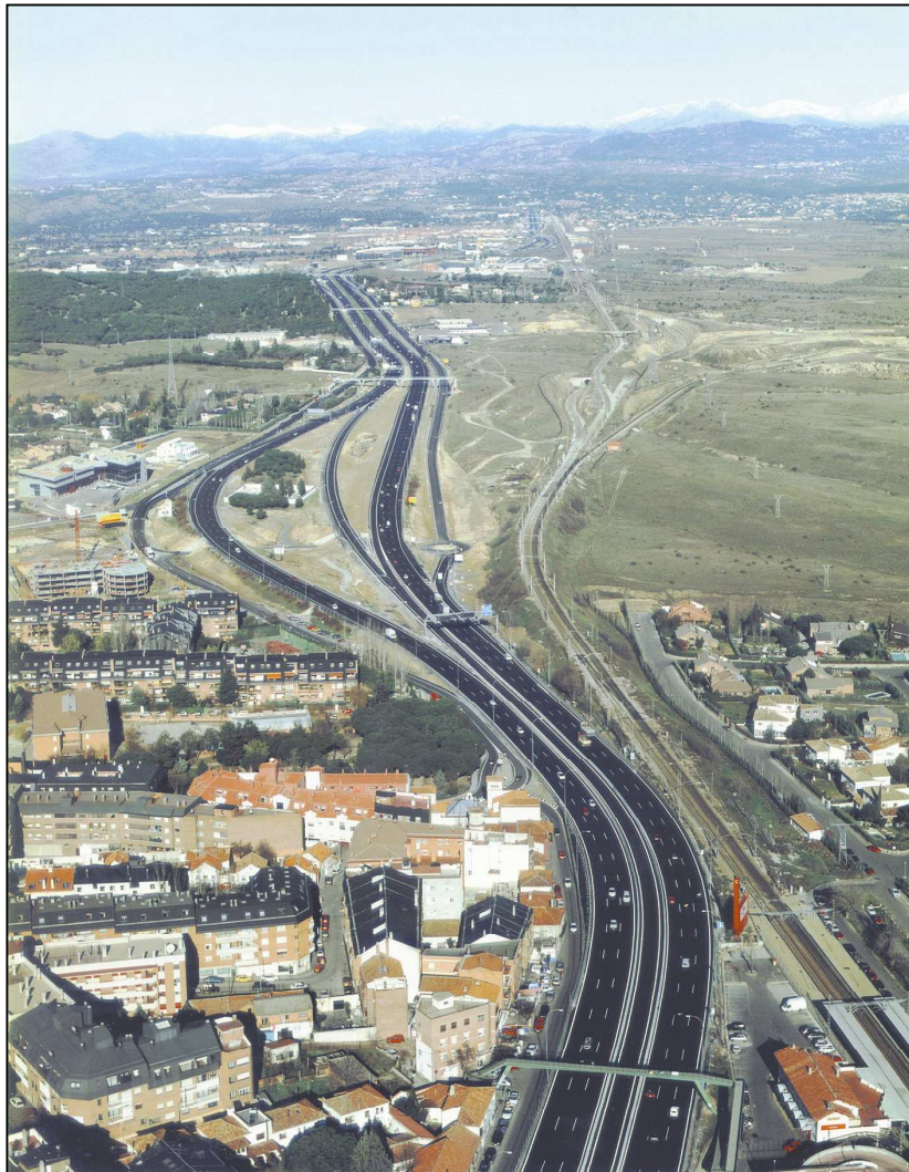
Madrid : vue aérienne du site propre VFO en direction de l'extérieur de l'agglomération
