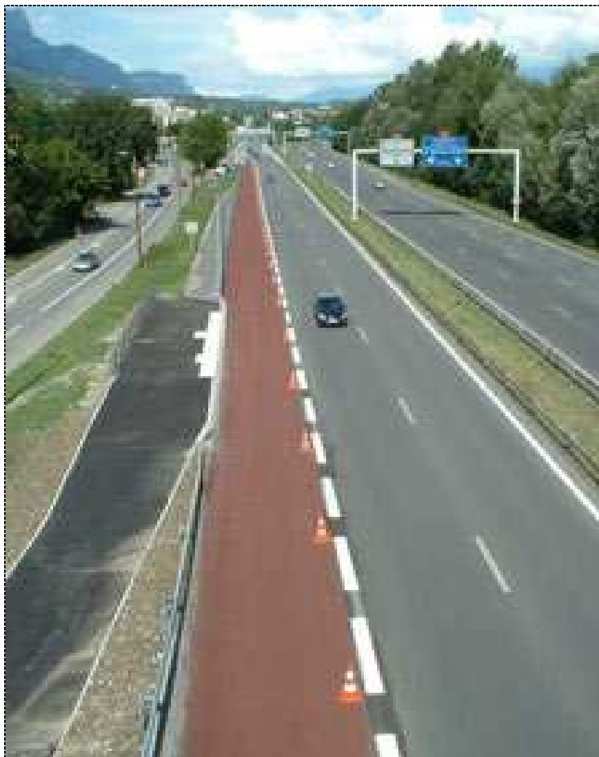
Grenoble : BAU transformée en couloir pour autobus suburbains sur la A 48
