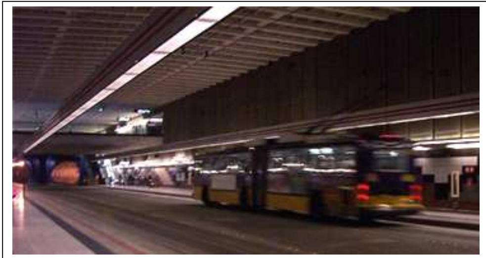
Tunnel pour autobus à Seattle
