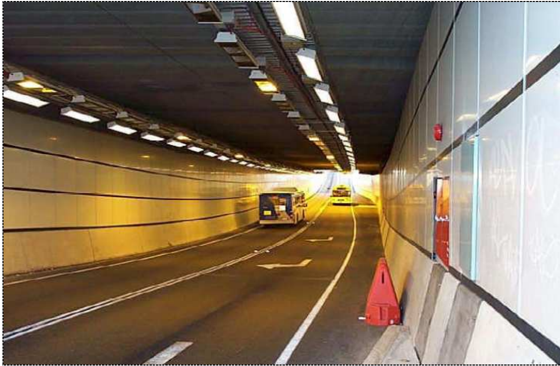
Brisbane : section de Busway en tunnel
