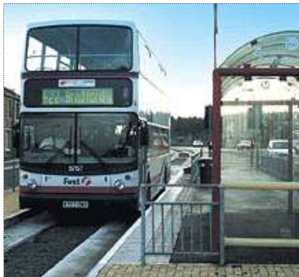
Bradford : Station d'une ligne de bus guidés
