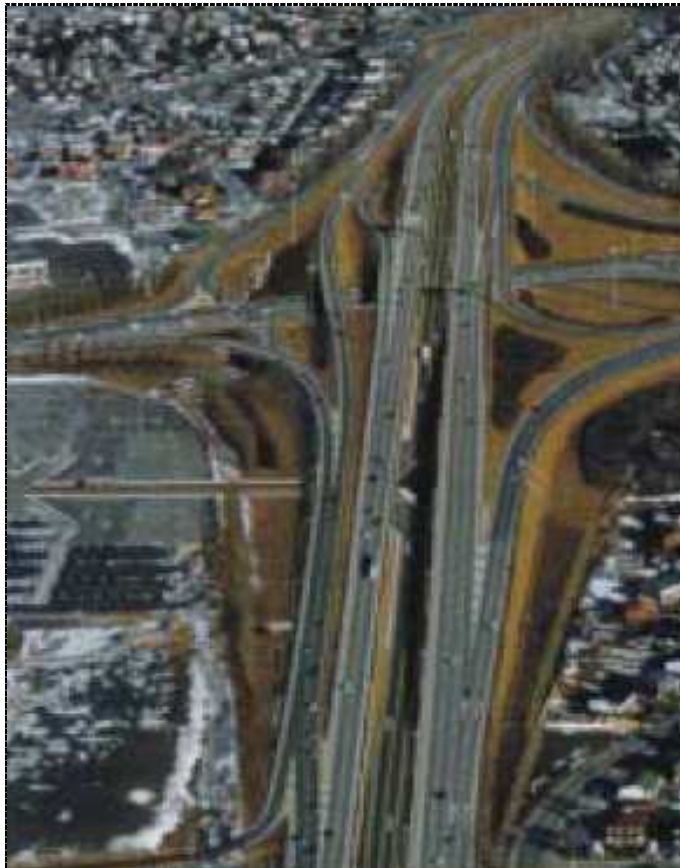
Montréal : Vue aérienne de l'autoroute urbaine A10 et de son corridor axial
