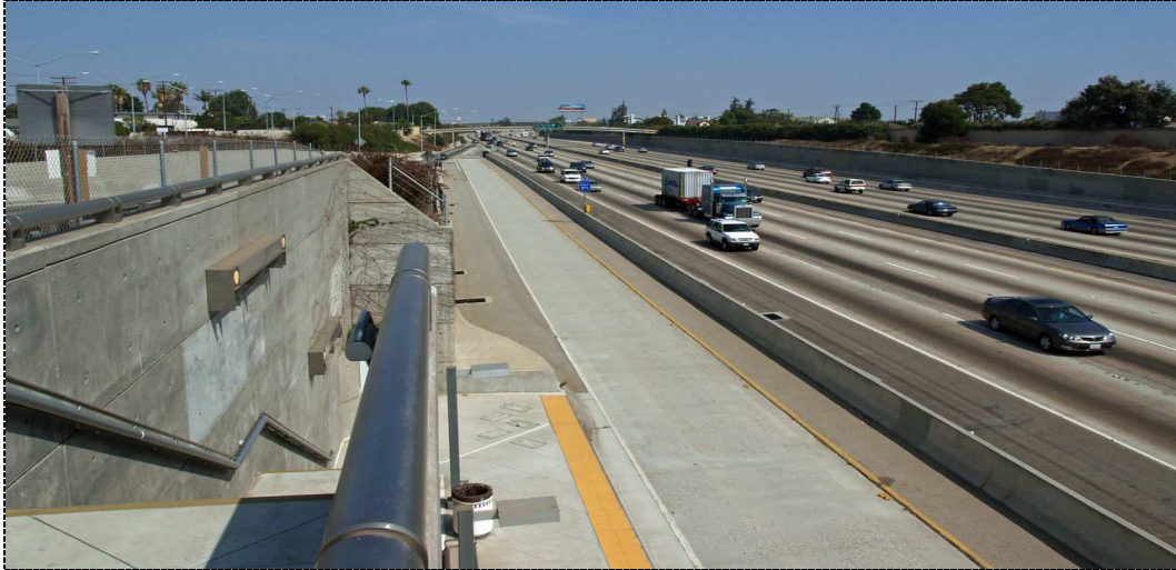
« Harbour Transitway » à Los Angeles : voie de droite réservée aux autobus, avec station.
