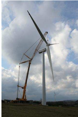
Chantier de levage d'une éolienne (crédit photo DDE/SUE/EDD)
