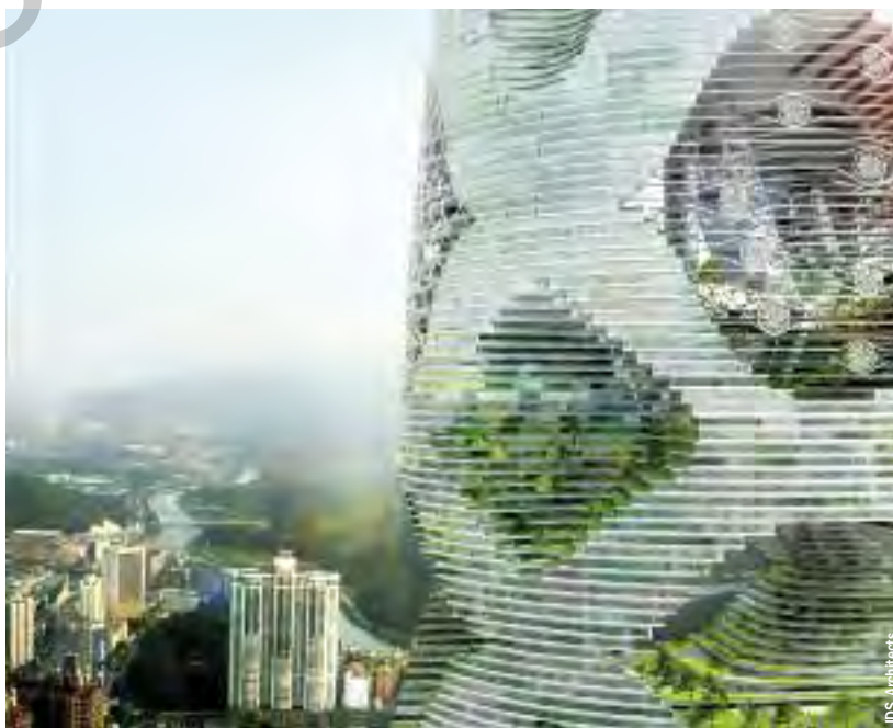
Julien de Smedt réinvente la ville verticale, où les vides créés dans les façades des tours deviennent de véritables espaces verts autour desquels se développent des lieux de vie.
