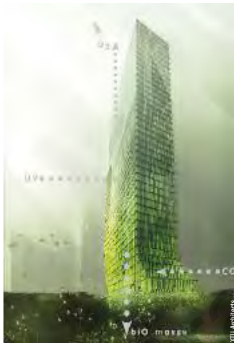
La culture des algues en façade de la tour biO2 est un procédé innovant pour produire de l'énergie.
