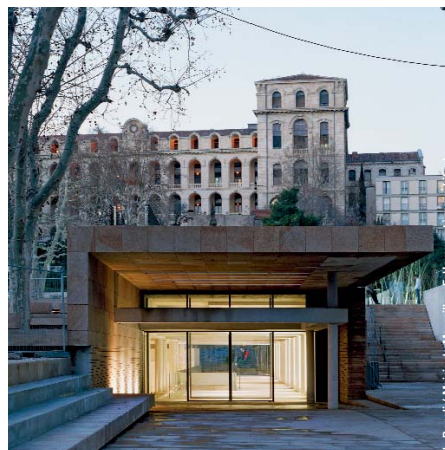
Extension de la mairie de Marseille. La construction des bureaux en souterrain a permis de dégager une place publique.
