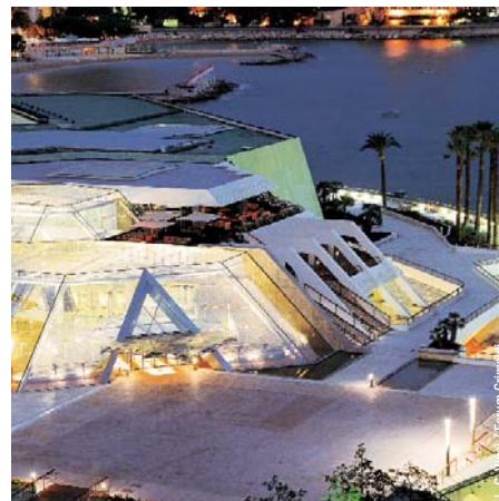
Forum Grimaldi, Monaco. Le centre de congrès, construit en majorité en souterrain permet de dégager une esplanade sur la mer.
