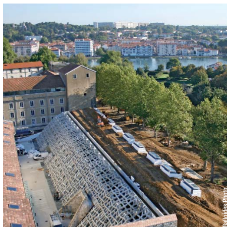
Bibliothèque universitaire de Bayonne. La salle de consultation est en façade et les puits de lumière servent aux espaces de stockage en souterrain.
