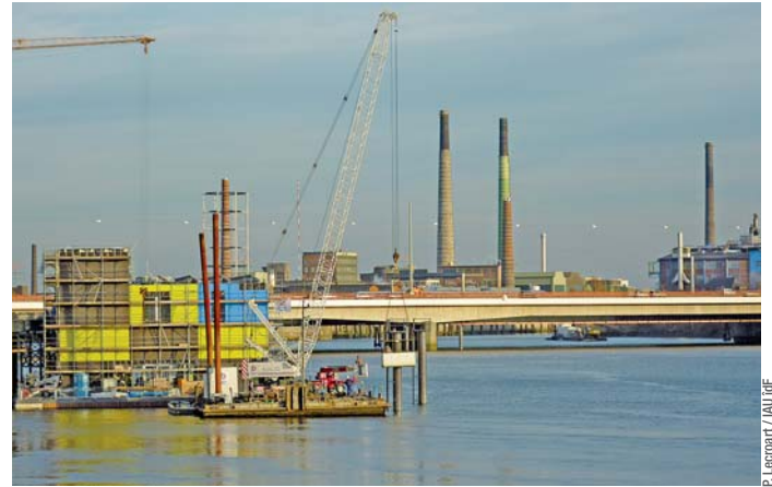
IBA Dock, siège de l'agence IBA, en construction, novembre 2009.
