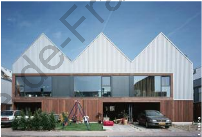
Une architecture inspirée des fermes, des façades en cèdre rouge et taules d'acier.
