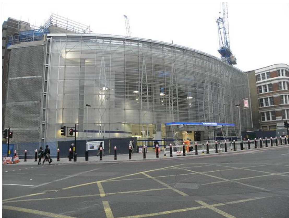
La nouvelle entrée nord de la station Blackfriars
