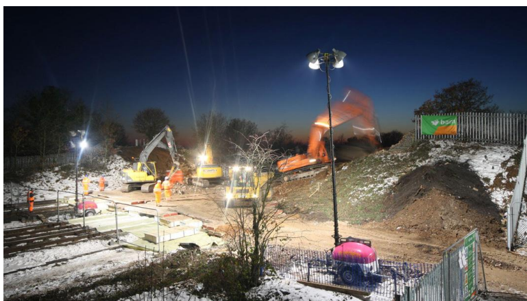
Vue du chantier CrossRail
